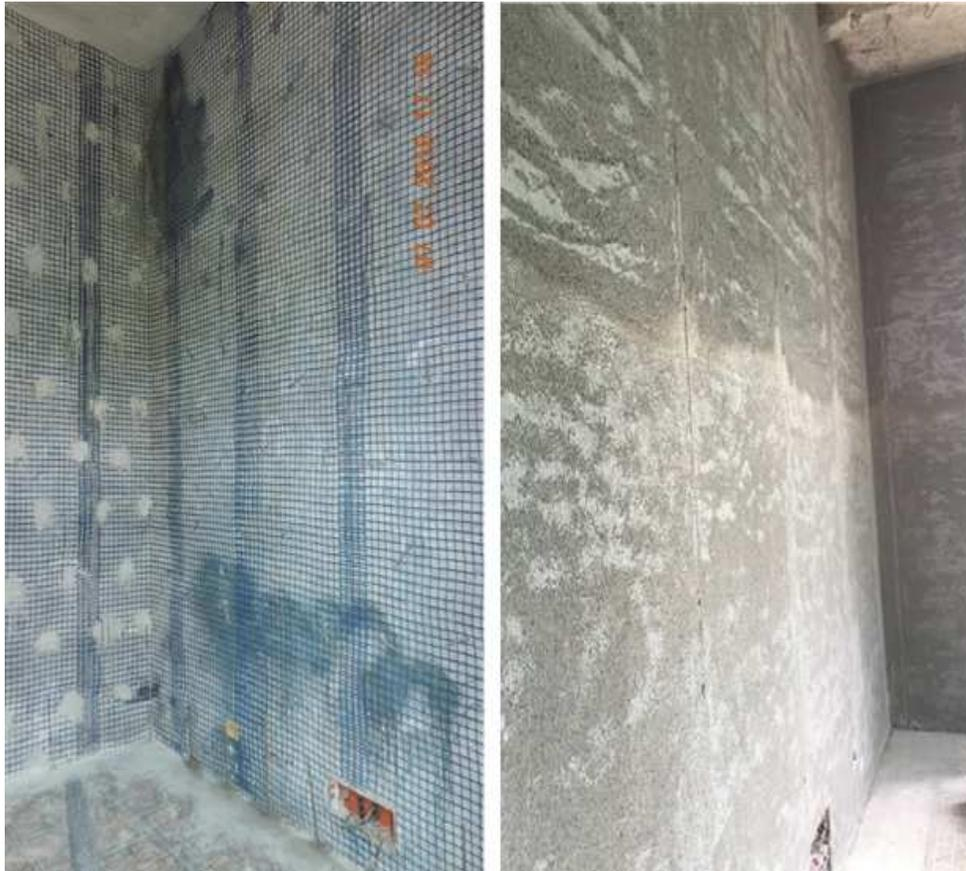
Qui in adiacenza, una foto della rete in fibra di vetro stesa in corrispondenza dei paramenti murari, ed a seguire, una foto dell'intonaco armato realizzato. A seguire una pianta tipo del villino con evidenziate in rosso le murature oggetto di consolidam
